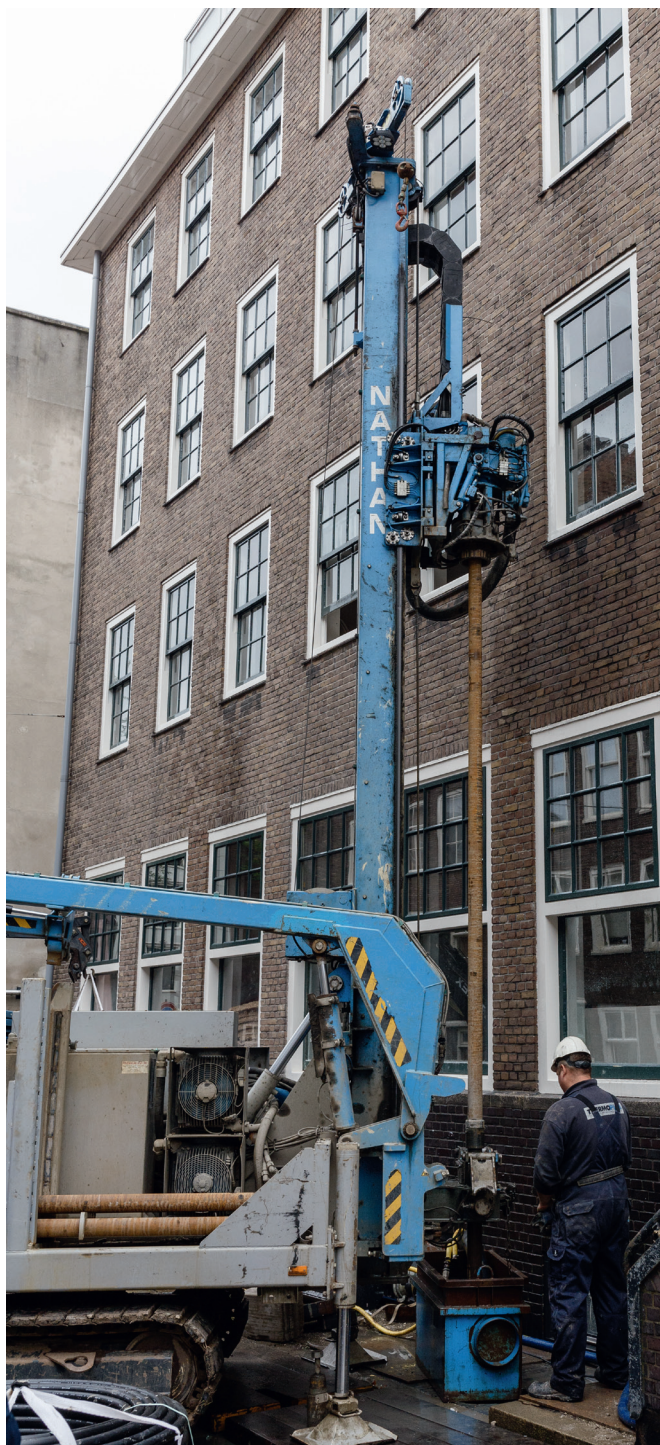
BRONBORINGEN NATHAN PROJECT AAN DE STRAAKTANT: PASSEN EN METEN
