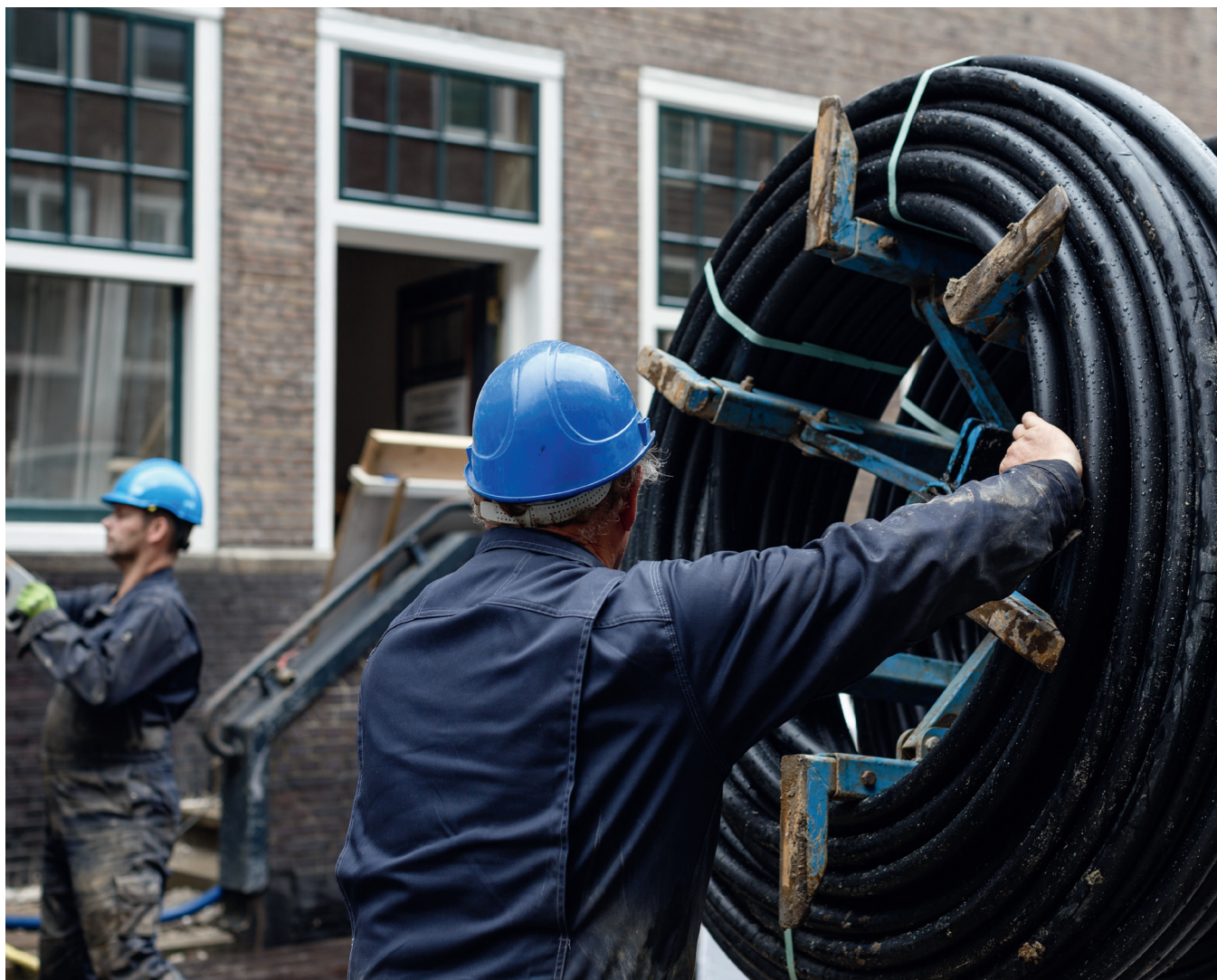
HET NATHAN PROJECTS BOUWTEAM AAN HET WERK AAN DE MONTELBAAANSTRAAT
